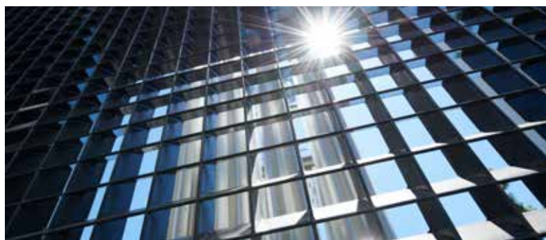
Links: Press- und Jalousieroste am OneonOne House in Luxemburg Oben: Detailaufnahme am OneonOne House Unten: Jalousieroste am Frauenhofer IPM
