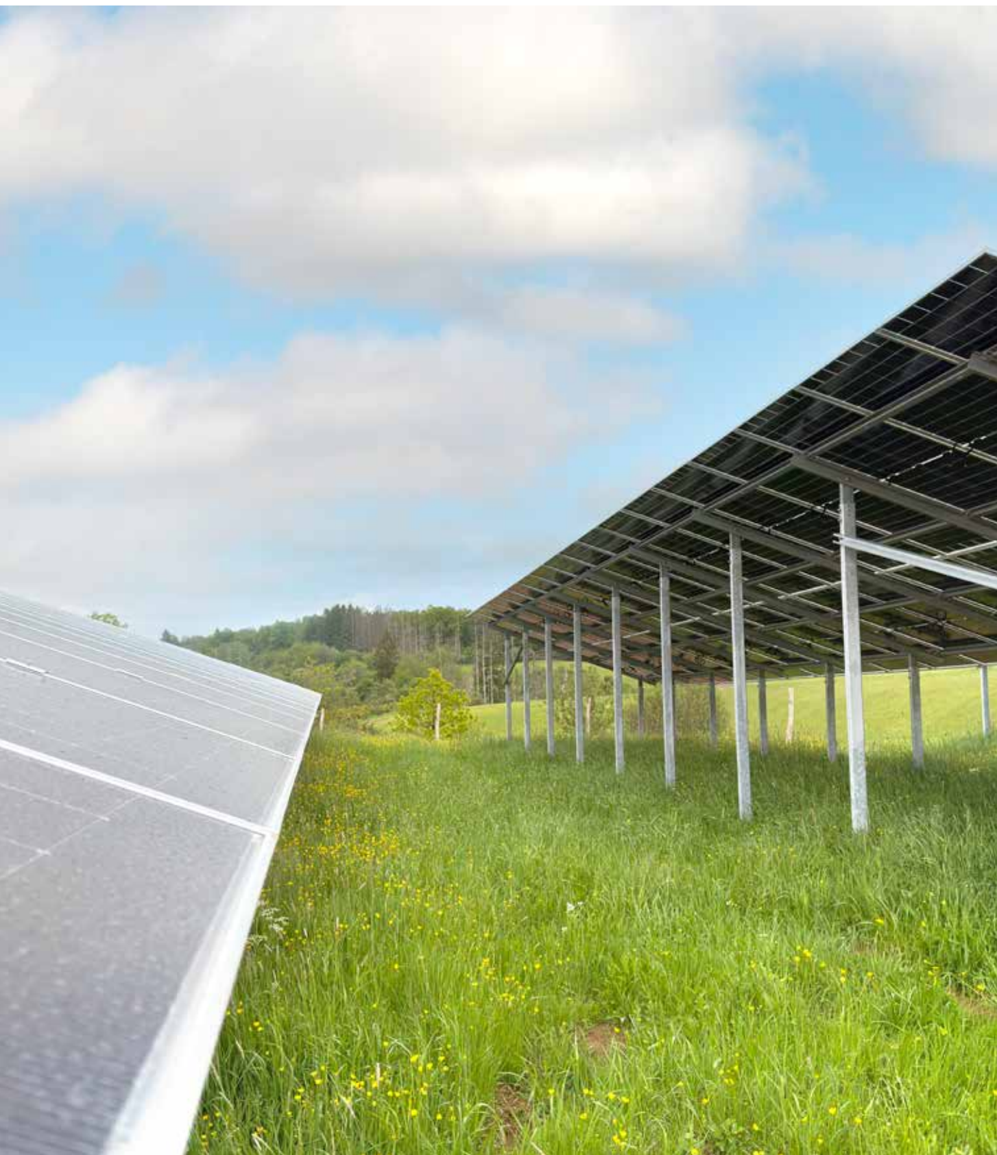
Le système de montage bipode MEISER Portrait dans un parc solaire à Nonnweiler
