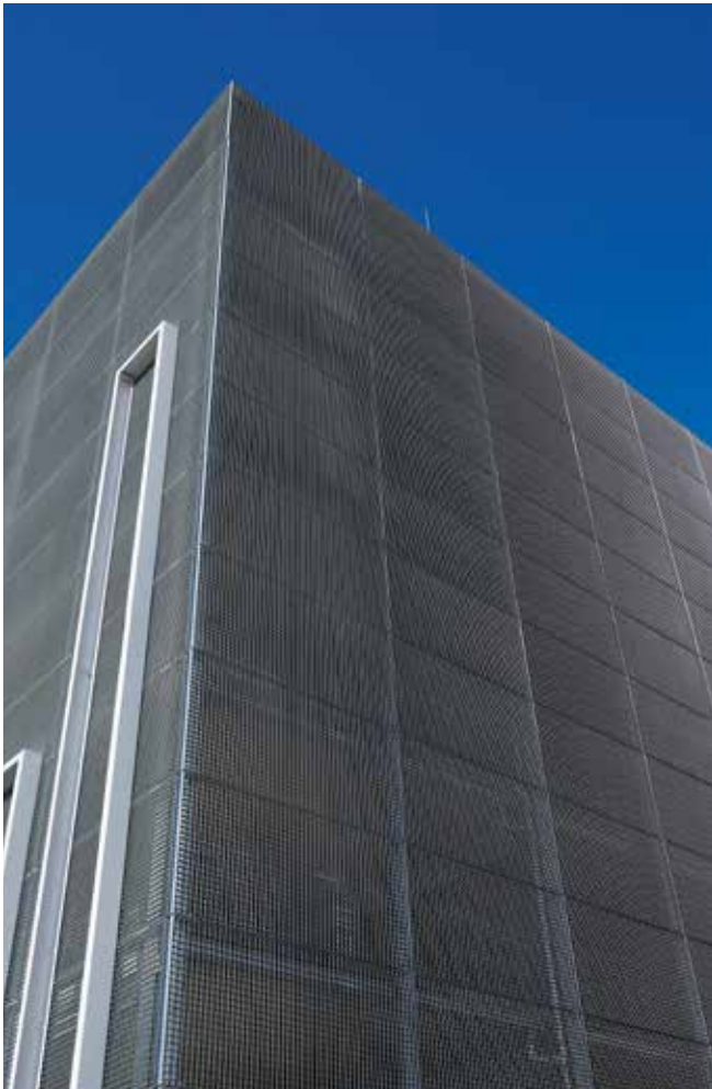
Auch als architektonisches Fassadenelement überzeugen Gitterroste, wie hier beim Balluff-Parkhaus in Neuhausen auf den Fildern
