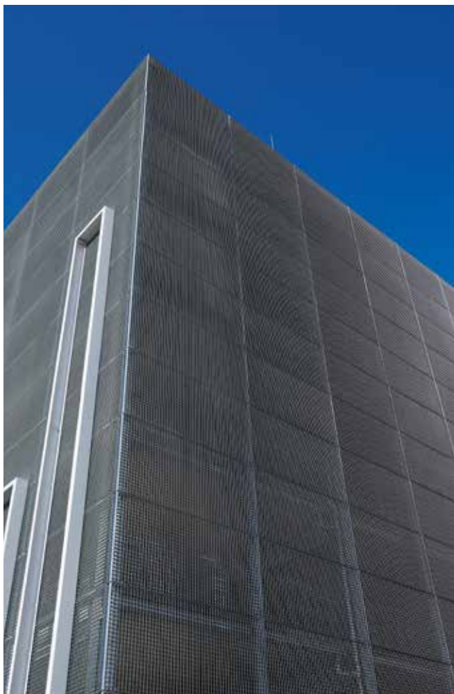
Las rejillas también resultan muy atractivas como elemento arquitectónico de fachada, como se puede apreciar aquí en el aparcamiento de Balluff, en Neuhausen auf den Fildern
