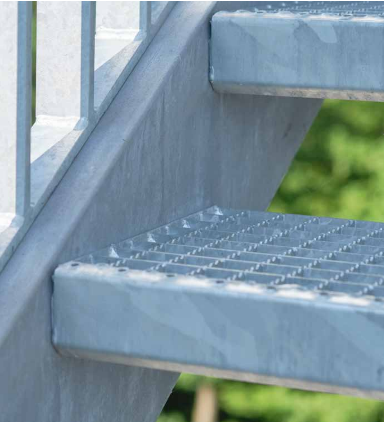
Pressroststufen mit Gleitschutz an der Gobelwarte Grein
