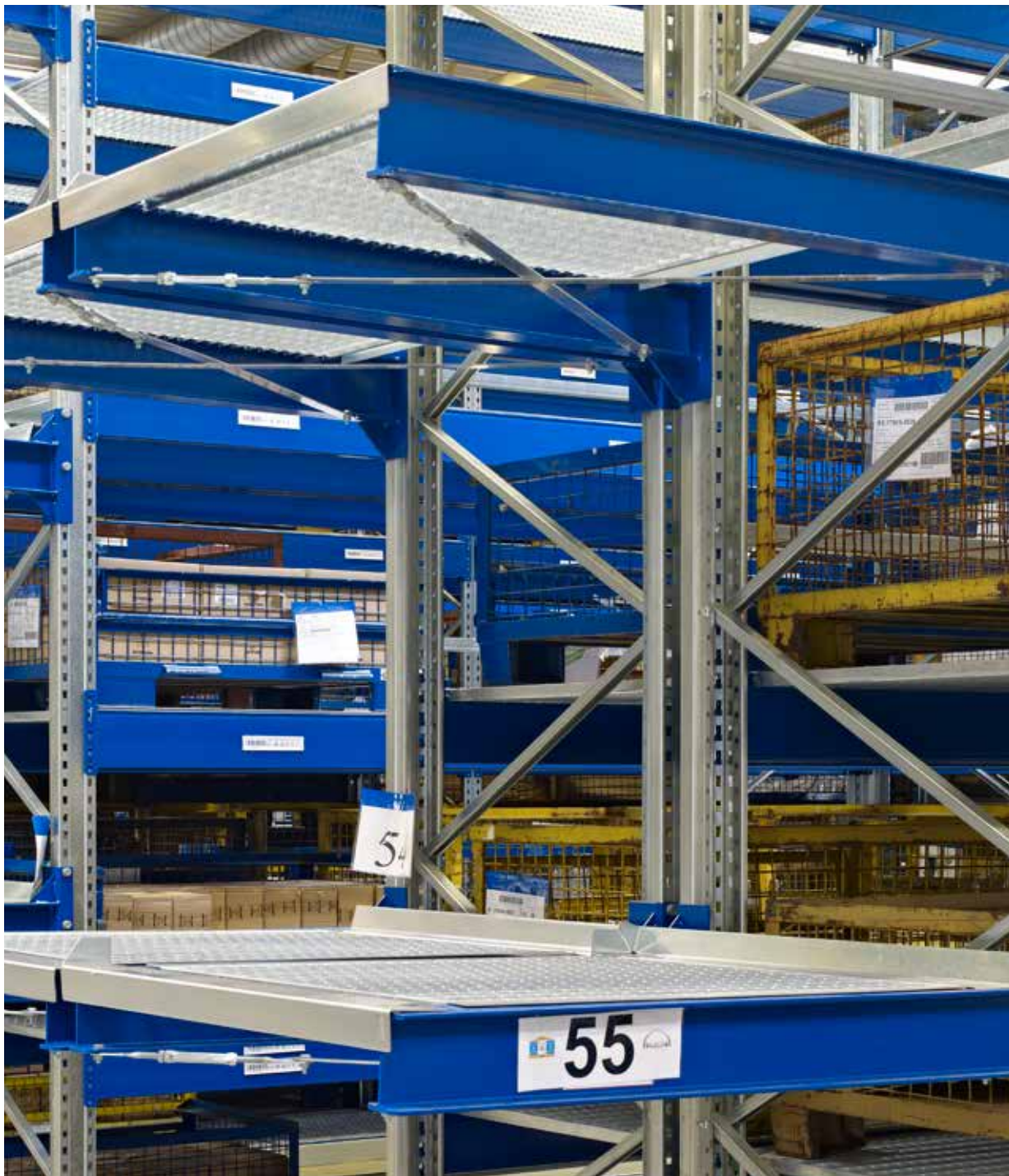
MEISER Regalroste bei MAN in Dachau
