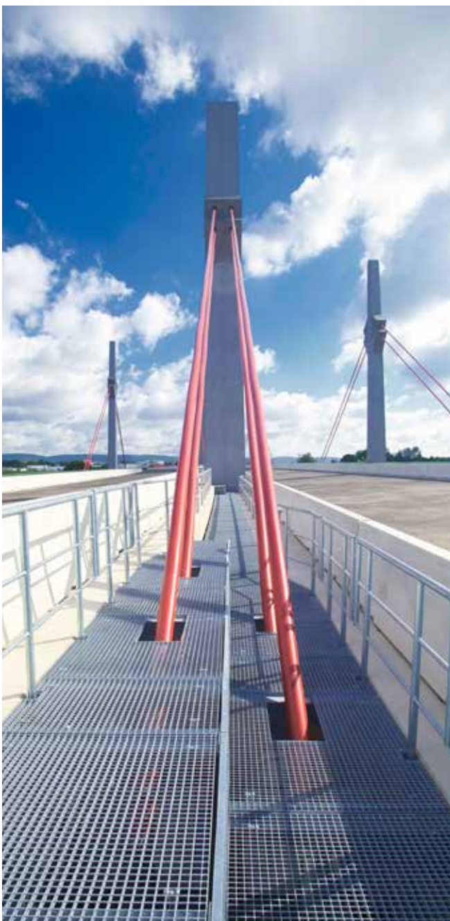
Gitterroste von MEISER als Laufweg auf der Brücke Bad Oeynhausen
