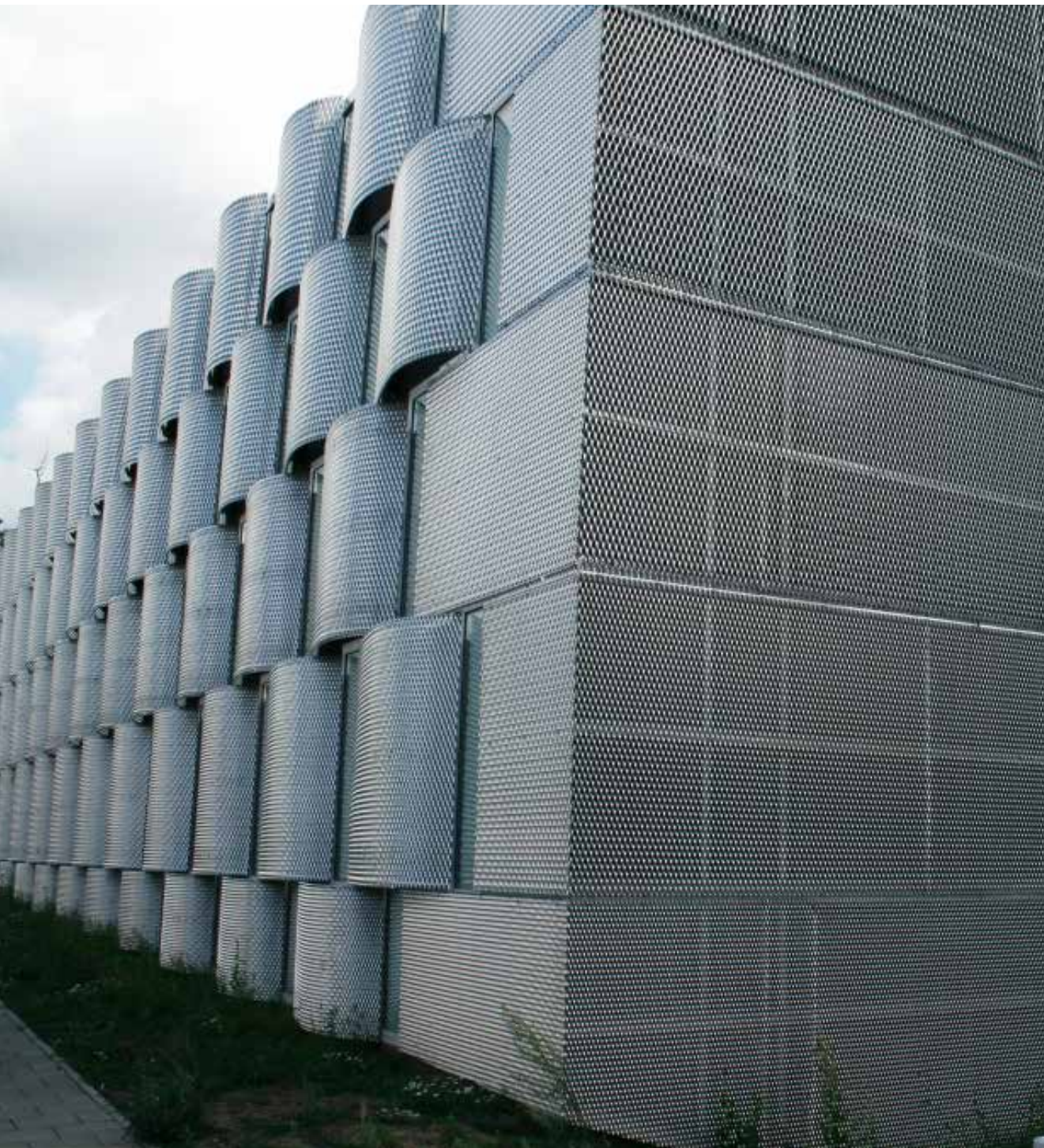
Sporthalle Reiferbahn, Schwerin
