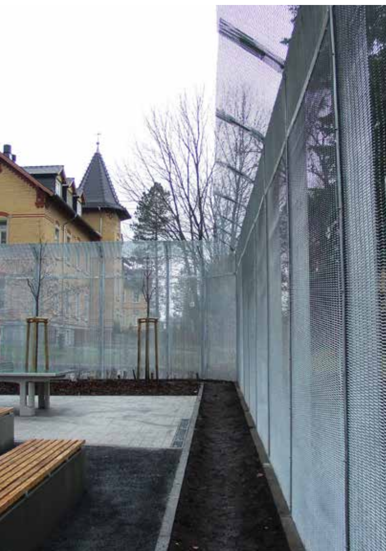
Modern und robust: Streckmetall-Zäune verbinden Sicherheit mit offener, klarer Optik
