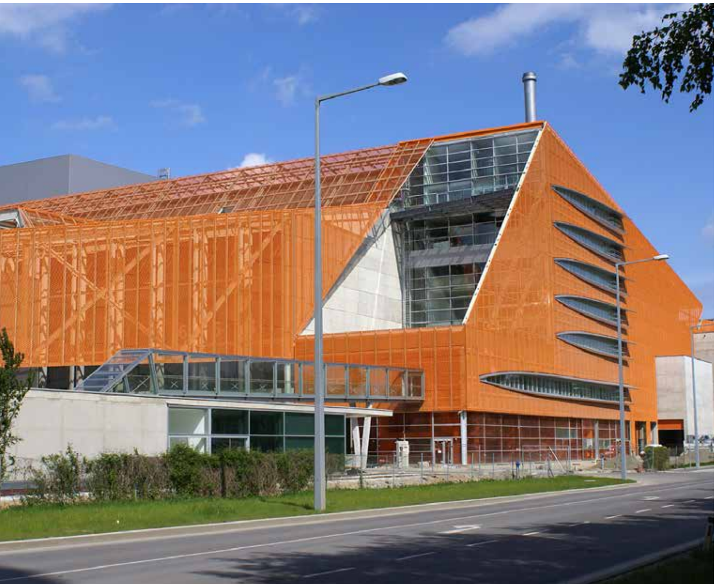
Echtes Farbstatement: Pulverbeschichtetes Streckmetall an der MVA in Wien
