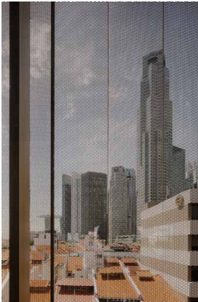
Durch die Streckmetallfassade der Garden Curtain Wall fällt der Blick auf die Skyline von Singapur
