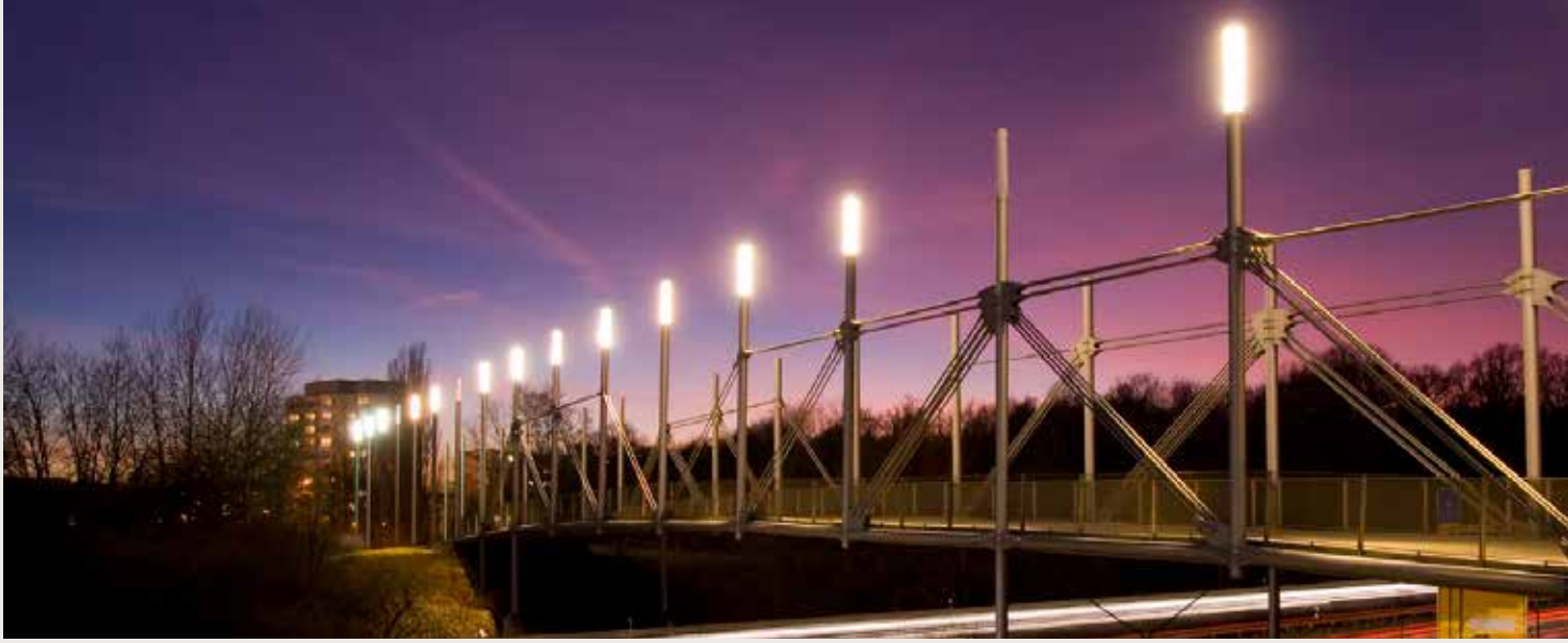
Streckmetall an der Fußbrücke zur Expo 2000
