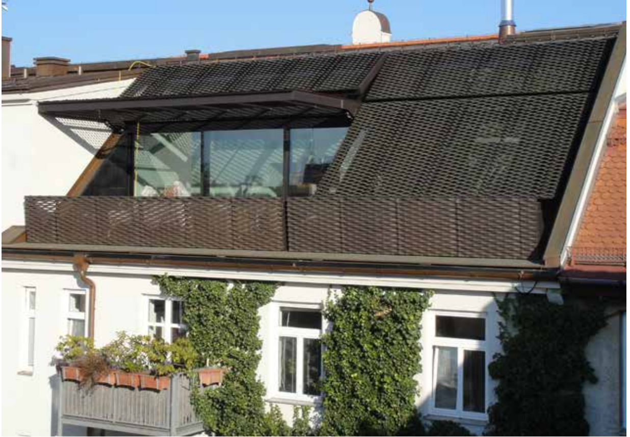
Streckgitter sorgt für langlebige Abdichtung und klare Linienführung
