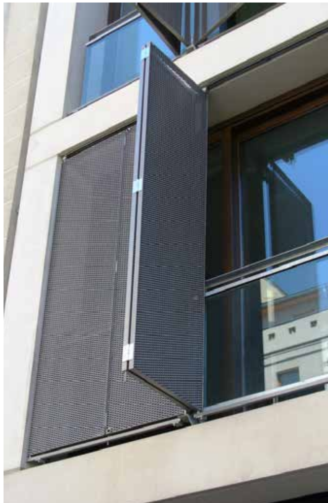
Streckmetall vereint Sichtschutz und Transparenz und ist daher ein beliebtes Fensterelement
