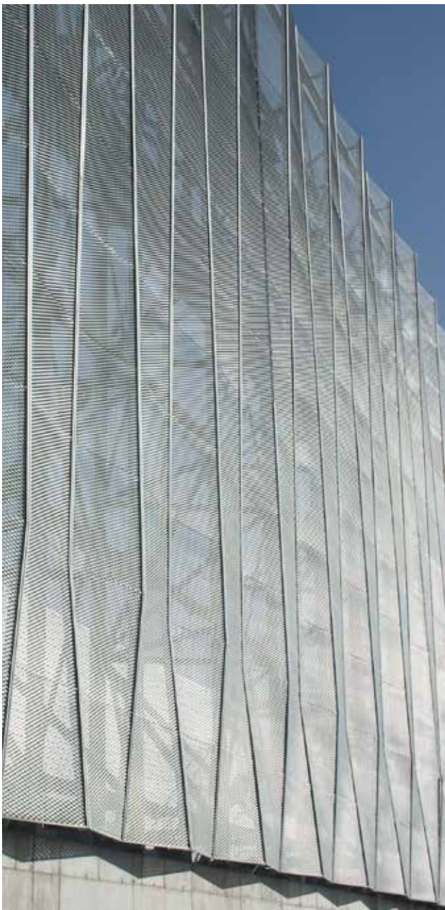
Pulverbeschichtetes Streckmetall als Fassadenverkleidung des Bilbao Centers in Spanien
